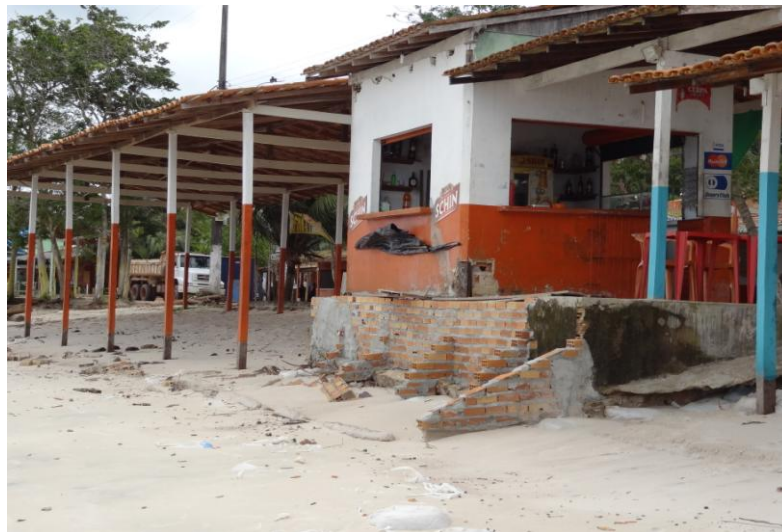
Figura 30: Efeito da erosão provocada pelas marés em uma das barracas na praia do Caripi.
