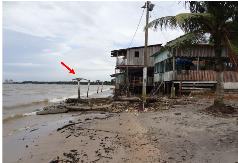
Figura 34: Efeito erosivo das marés em unidades ocupacionais na Praia de Vila do Conde. Notar no centro fiducial da imagem a evidência de erosão no que seria um pequeno terraço que abrigavam guardas-sol fixos.
