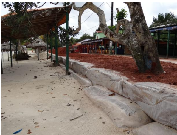
Figura 32: Obra de contenção ao processo erosivo e recuperação da via que margeia a Praia do Caripi.
