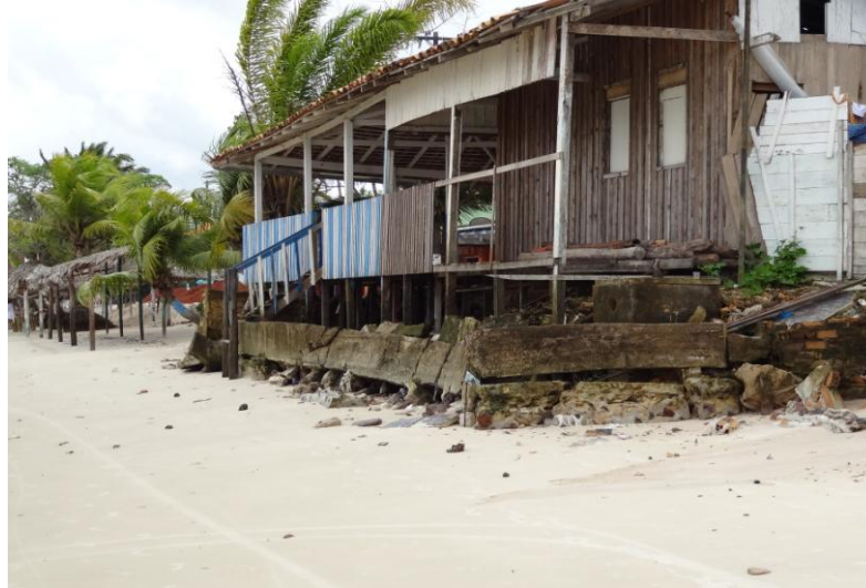
Figura 31: Obra de contenção em concreto armado para proteção da estrutura de uma barraca na praia do Caripi.
