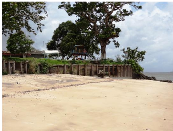
Figura 39: Estrutura de contenção a erosão na Praia de Itupanema.
